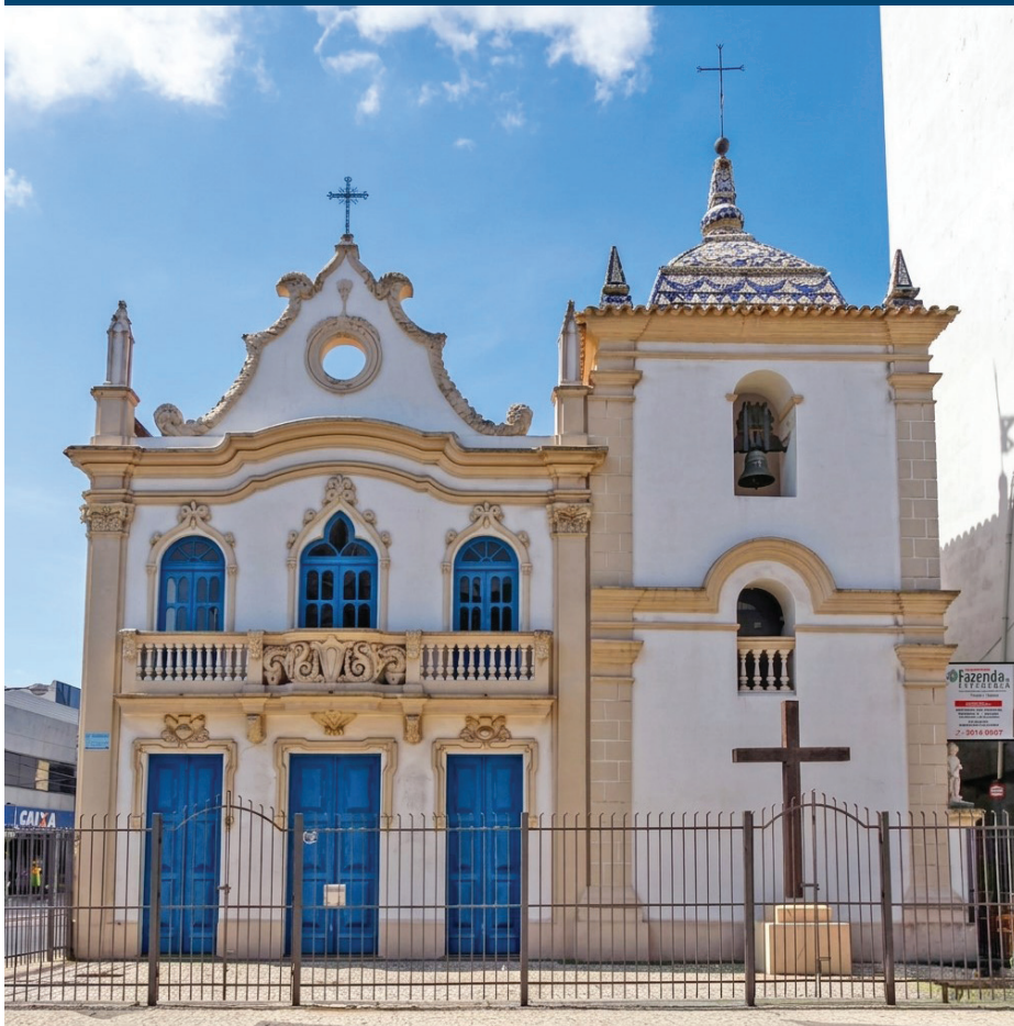
Restauração da Igreja Nossa Senhora dos Remédios, obra entregue em 04.05.1998.
