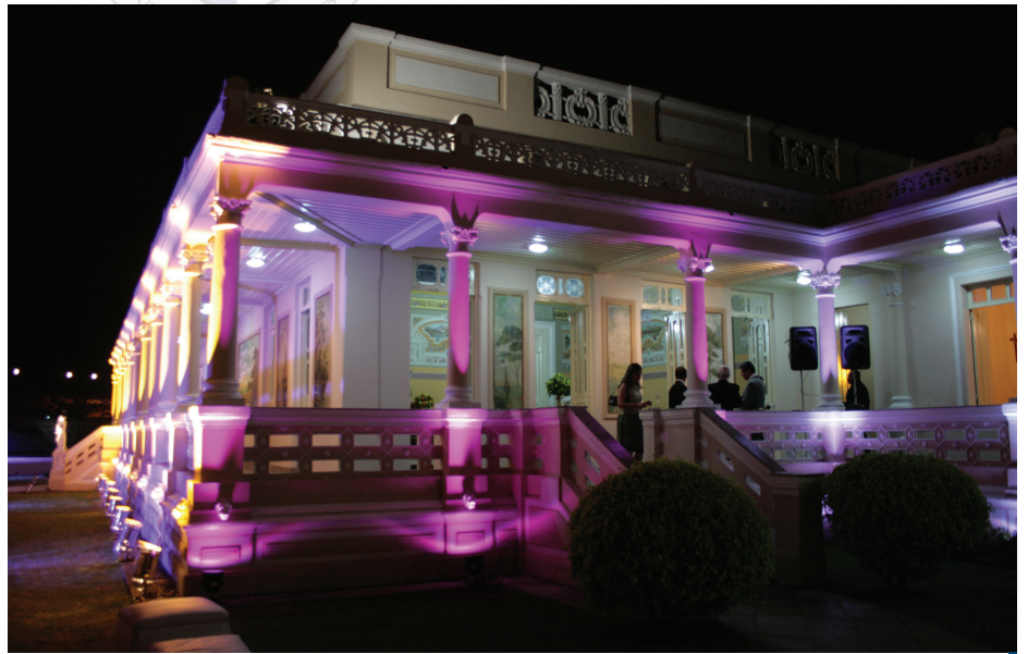
Aquisição e restauração do Casarão Fróes da Motta (de 1902), único existente na cidade, resgatando a memória de um passado – inaugurado em 21 de novembro de 2008.
